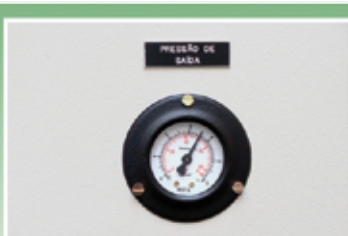
Manômetro indicador da pressão de saída de água gelada para melhor controle do processo.
